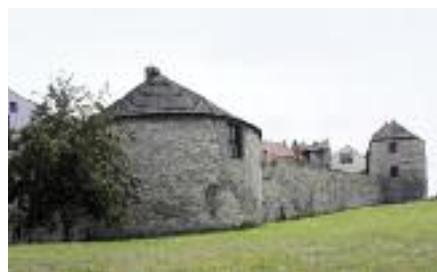
Bašty městského opevnění (Louny)
