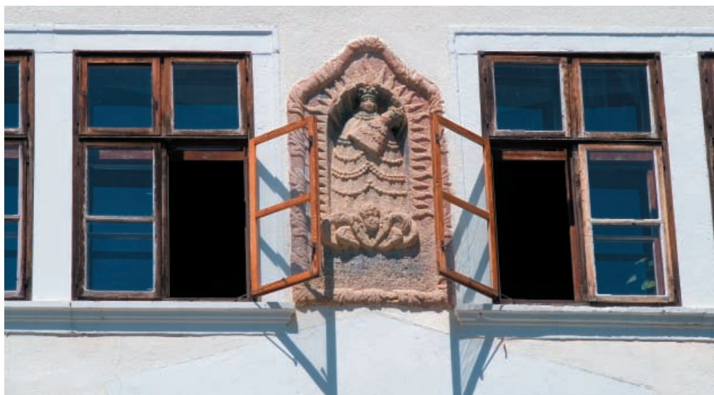
▲ Detail južného priečelia Draškovičovho kaštieľa
