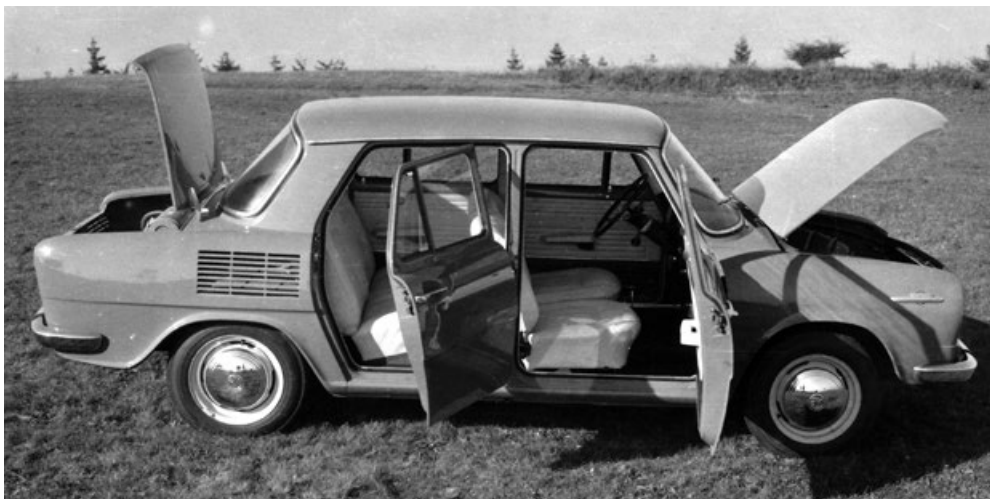
Zcela otevřený prototyp Š 717, závěsy kapoty motoru byly umístěné zvenku
